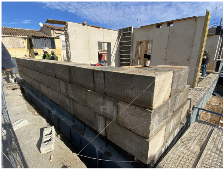
Montage des Murs en gros blocs de terre et Murs refends intérieur en béton de site
