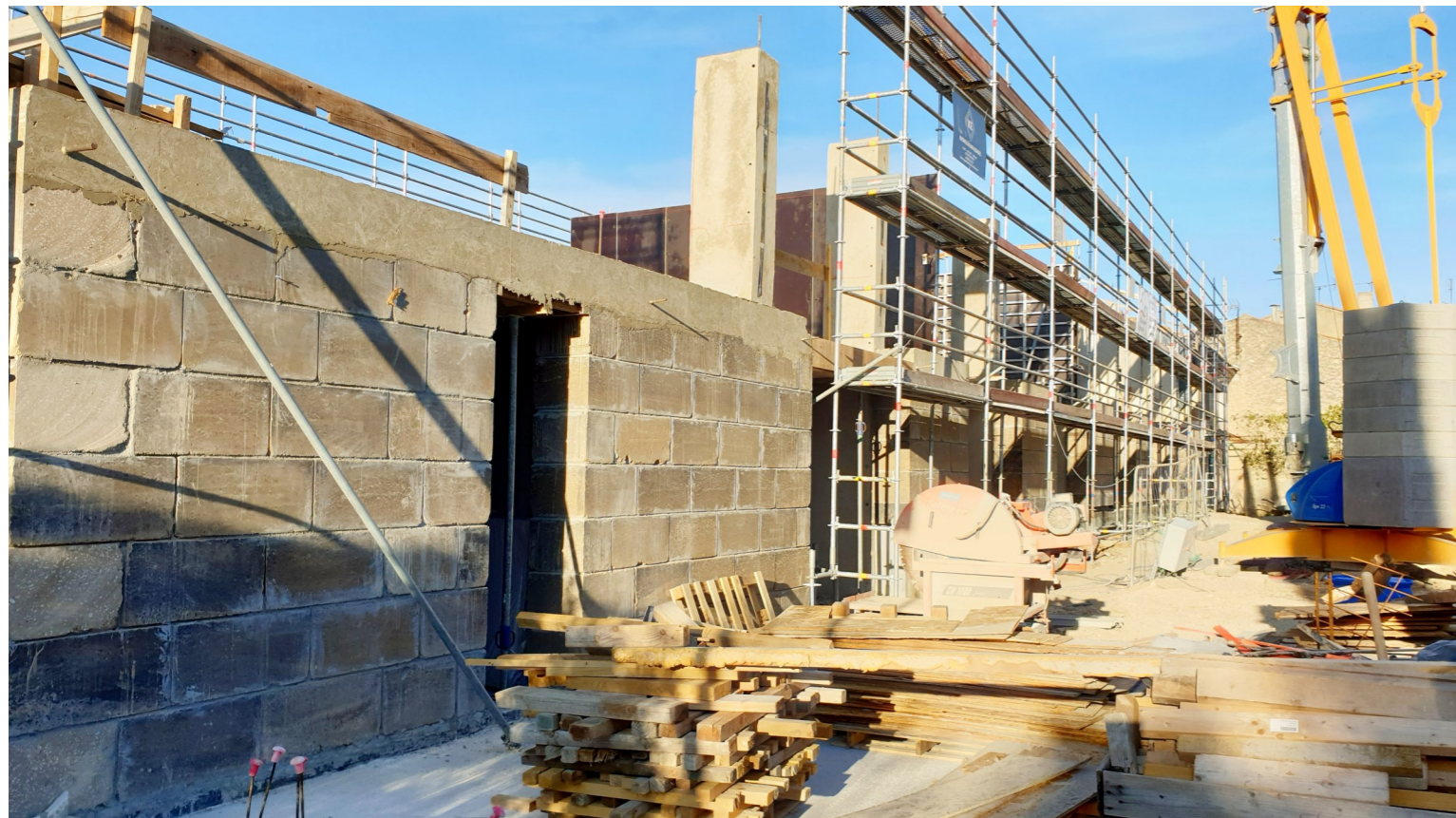
Murs en gros blocs de terre et béton de site
