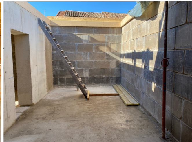
Murs en gros blocs de terre et béton de site
