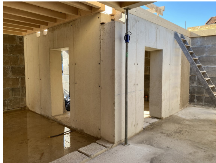
Montage des Murs en gros blocs de terre et Murs refends intérieur en béton de site
