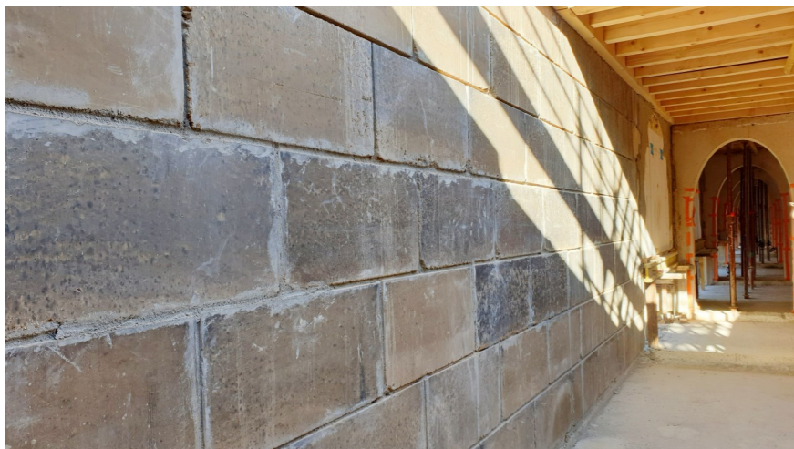
Murs en gros blocs de terre et béton de site
